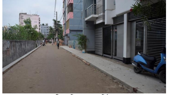
গ্রামীণ আবাসিক এলাকায় ড্রেন নির্মাণ।
