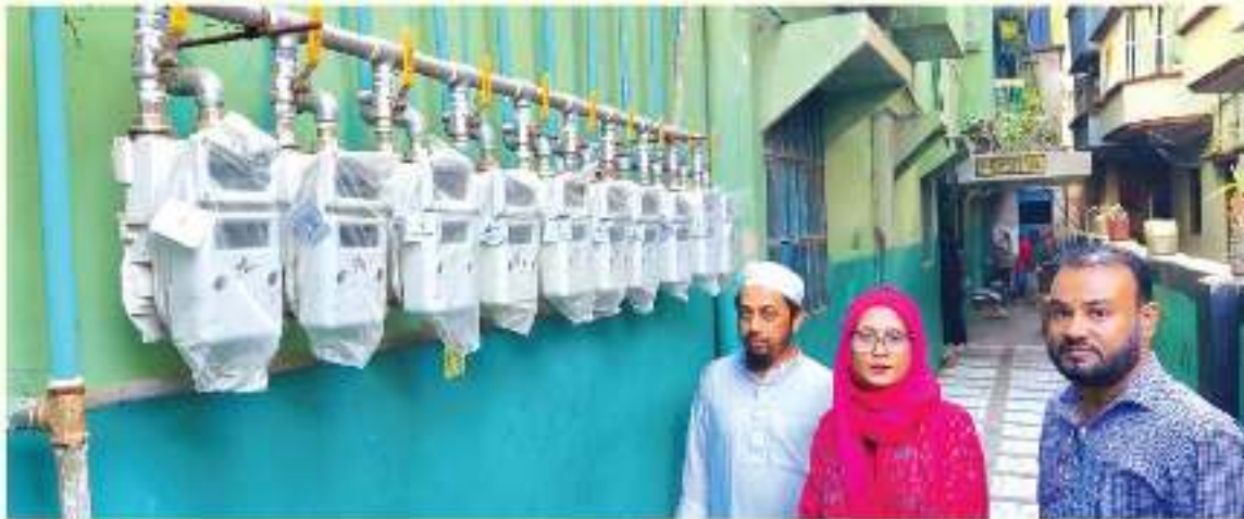
। আবাসিক গ্রাহকের অভ্যন্তরীণ প্রি-পেইড মিটার স্থাপন কার্যক্রম পরিদর্শন।
