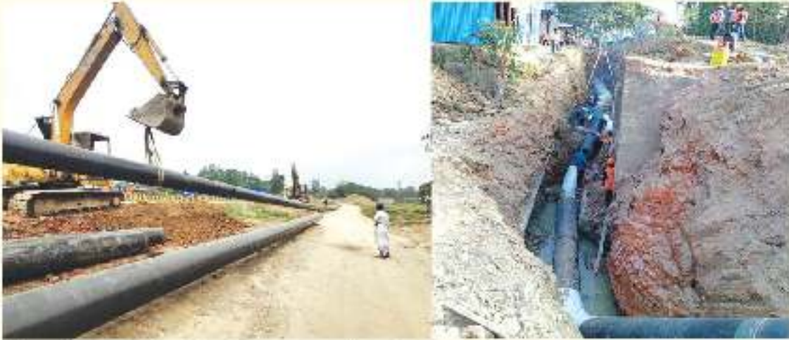
। মিরসরাই এলাকায় আপগ্রেডেশন প্রকল্পের আওতায় পাইপ লাইন স্থাপন কার্যক্রম।
