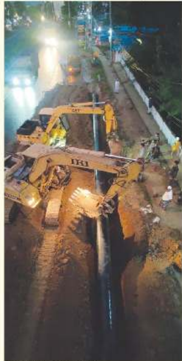
। গ্যাস পাইপ লাইন স্থাপন কার্যক্রম।
