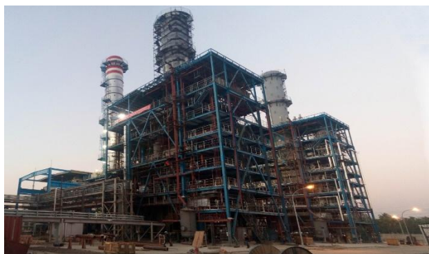
Figure 31: Vertical type HRSG
