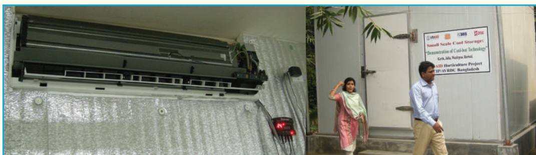
চিত্র-৩৮: কুলবট কোল্ড স্টোরেজে এয়ার কন্ডিশনারের সাথে সংযুক্ত কুলবোট ডিভাইস (বামে) ও কুলবট কোল্ড স্টোরেজ (ডানে)
