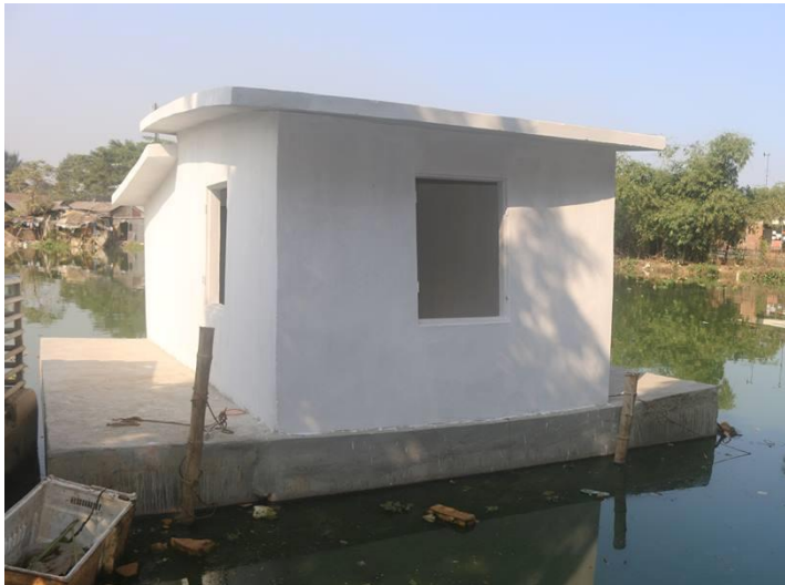
Expanded Polystyrene (EPS) ব্যবহার করে ফেরোসিমেন্ট প্রযুক্তিতে নির্মিত ফ্লোটিং হাউজ
