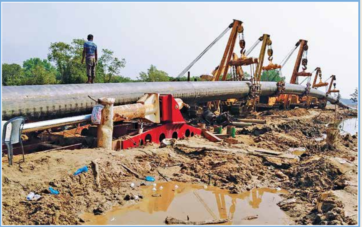
৩০" ব্যাসের বগুড়া-রংপুর-সৈয়দপুর গ্যাস সঞ্চালন পাইপলাইন প্রকল্পের HDD পদ্ধতিতে নদী ক্রসিং কার্যক্রম
