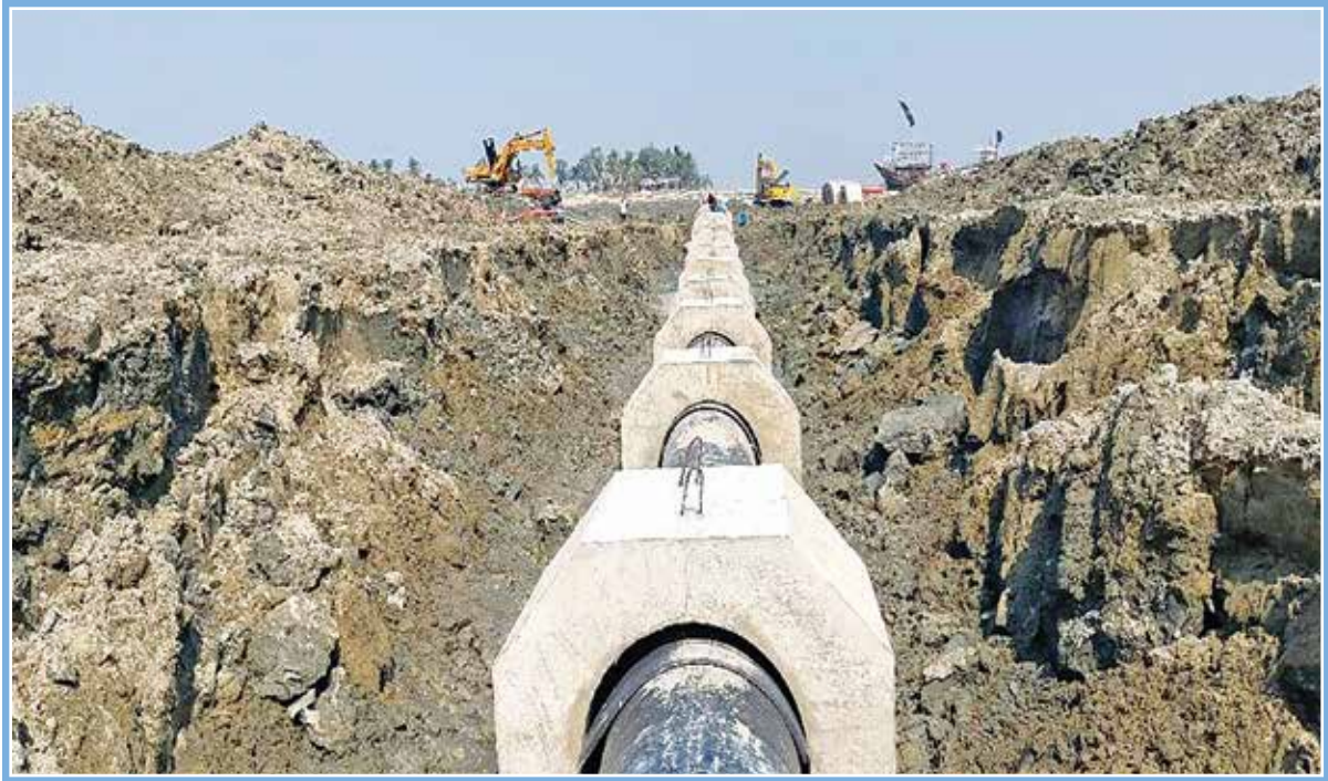
চট্টগ্রামস্থ পতেঙ্গায় ৪২ ইঞ্চি ব্যাসের আনোয়ারা-ফৌজদারহাট গ্যাস সঞ্চালন পাইপলাইন পথস্বত্বের রক্ষণাবেক্ষণ কাজ
