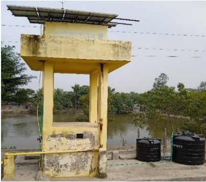
চিত্র-১: Pond Sand Filter
