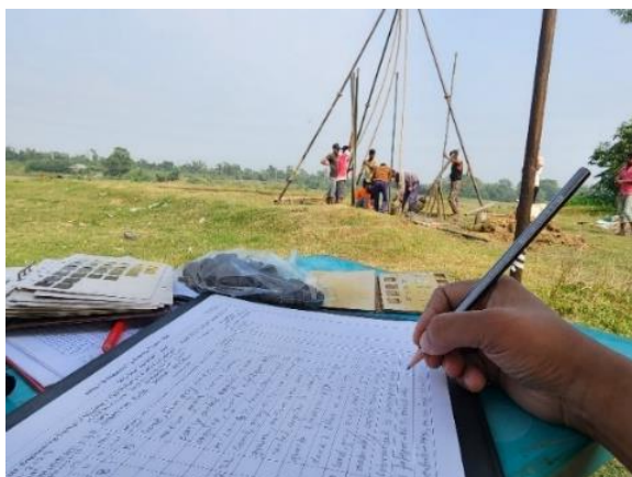
চিত্র ৯: ভূপ্রকৌশল কুপ খনন কার্যক্রম ও লগ প্রস্তুতকরণ
