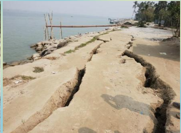
চিত্র: নদী ভাঙ্গন এ তীরে ফাটলের সৃষ্টি
