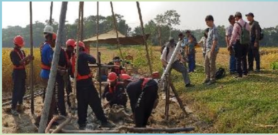
ভূপ্রকৌশল কূপ খনন কার্যক্রম, বরিশাল, ডিসেম্বর ২০১৮
