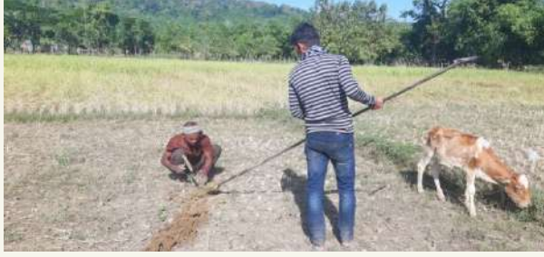
চিত্র : দক্ষিণ শ্রীপুর, তাহিরপুর উপজেলায় অগার কূপ খনন
