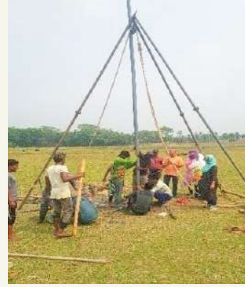
চিত্র : ভূপ্রকৌশল কুপ খনন কার্যক্রম পরিদর্শন
