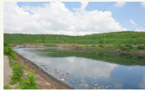
চিত্র : মাতুয়াইল ল্যান্ডফিল সাইটে লিচেট স্টোরেজ পুরুর
