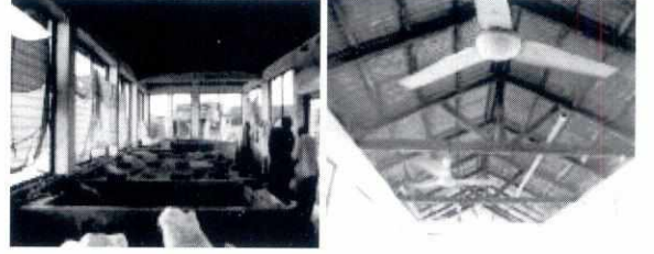
ছবি: গাইবান্ধা সরকারি মৎস্য হ্যাচারিতে তাপমাত্রা নিয়ন্ত্রণে পর্যাপ্ত বাতাস প্রবেশের সুব্যবস্থা
