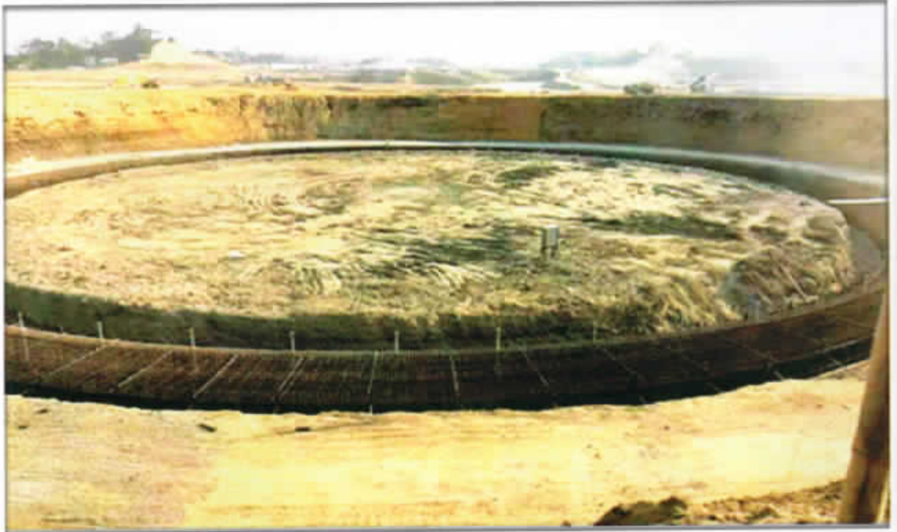
এসপিএম প্রকল্পের অধীনে মহেশখালীতে নির্মিত ব্যাস্টোরেজ ট্যাংকের ফাউন্ডেশন তৈরির কাজের চিত্র
