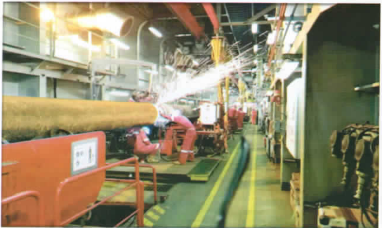
Hilong 106 বার্ড এর অভ্যন্তরে এসপিএম প্রকল্পের অফশোর পাইপলাইন ওয়েল্ডিং কাজের চিত্র
