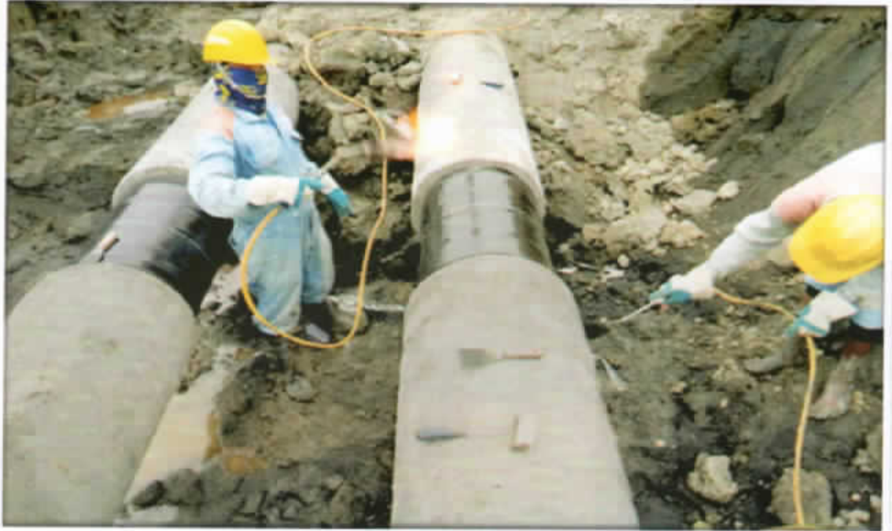
এসপিএম প্রকল্পের অধীনে মহেশখালীতে অনাশোর পাইপলাইনে কোটিং করার চিত্র
