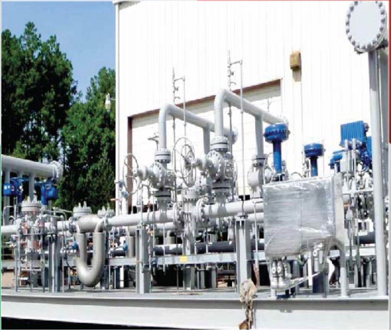
ইআরএল এ বাস্তবায়নধীন “ডিজাইন, সাপ্লাই, ইন্সটলেশন, টেস্টিং এন্ড কমিশনিং অফ কাস্টডি ট্রান্সফার ফ্লো মিটার উইথ সুপারভিজরি কন্ট্রোল” শীর্ষক প্রকল্পের ফ্লো মিটার কিড এর নমুনা
