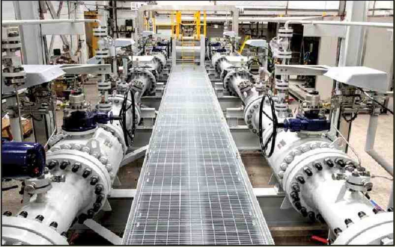
ইআরএল কর্তৃক বাস্তবায়নাধীন “ডিজাইন, সাপ্লাই, ইন্সটলেশন, টেস্টিং এন্ড কমিশনিং অফ কাস্টডি ট্রান্সকার ফ্লো মিটার উইথ সুপারভিজরি কন্ট্রোল” শীর্ষক প্রকল্পের নির্মাণাধীন ফ্লো মিটার কিউ।
