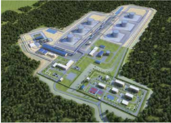
চিত্র: মহেশখালিতে নির্মাণাধীন পাম্পিং স্টেশন ও ট্যাংক ফার্ম এর থ্রিডি মডেল
