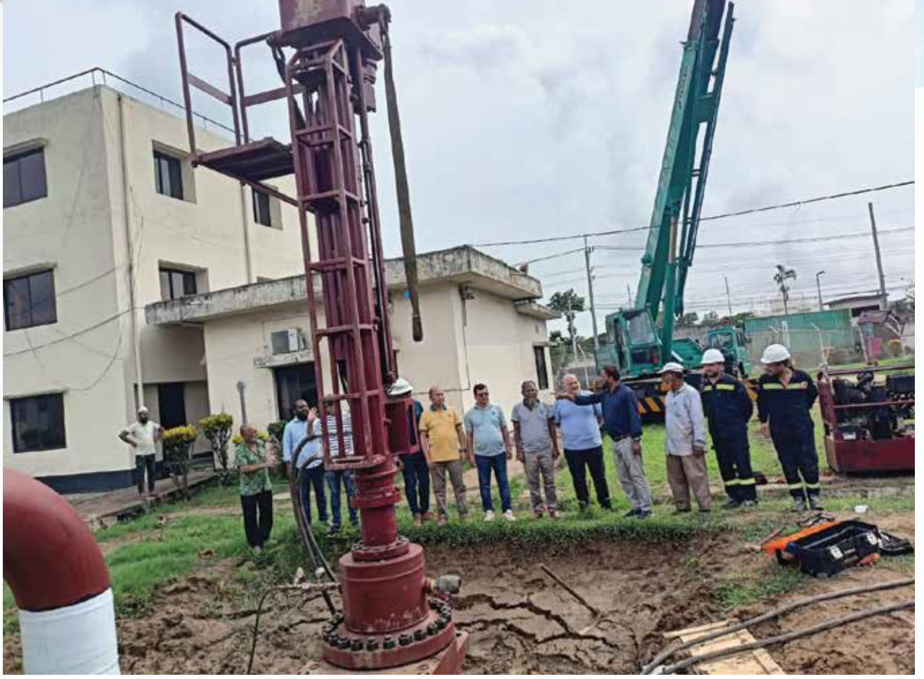
Installation and Modification of Gas Stations at Off-Transmission Points of GTCL Project এর আওতায় ফৌজদারহাট সিজিএস এ হট ট্যাপিং কার্যক্রম।
