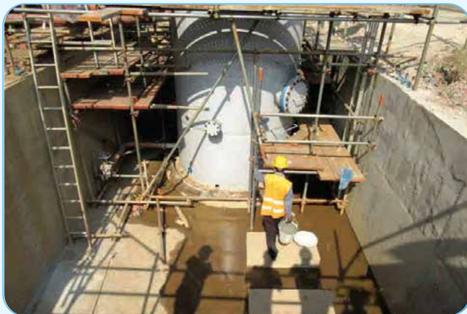
HRSG (grouting work)
