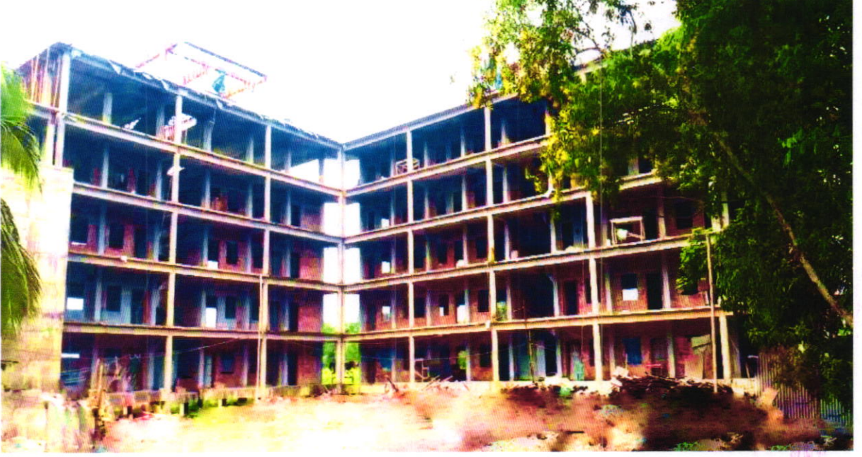
প্রকল্পভুক্ত নির্মাণাধীন মালিগাঁও উচ্চ বিদ্যালয়ের ৫তলা একাডেমিক কাম প্রশাসনিক ভবন
