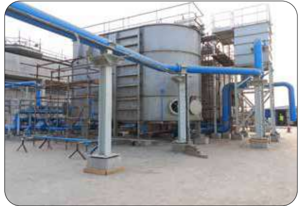
Figure 31: W71_Densadeg Thickener
