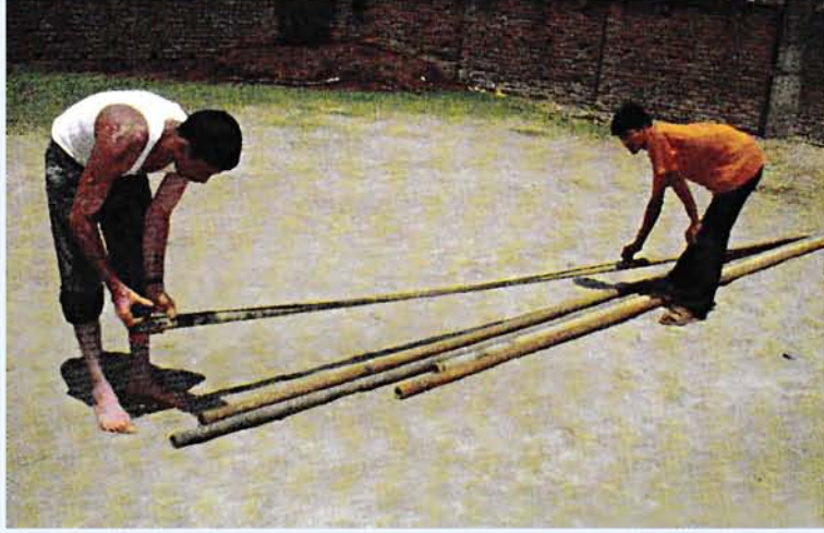
চিত্র ৯ খননের গভীরতা নির্ণয়ের জন্য ড্রিল পাইপের দৈর্ঘ্য মাপা প্রয়োজন
