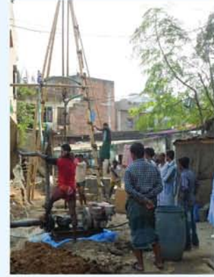
চিত্র ২ ডনকি পাম্প বা ওয়াটার জেট পদ্ধতি
