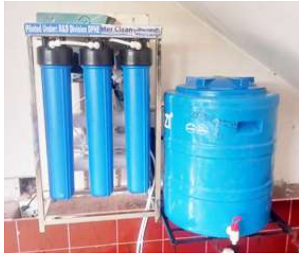
চিত্র: উচ্চমাত্রার লবণাক্ততার জন্য ছোটো আকারের রিভার্স অসমোসিস ইউনিট
