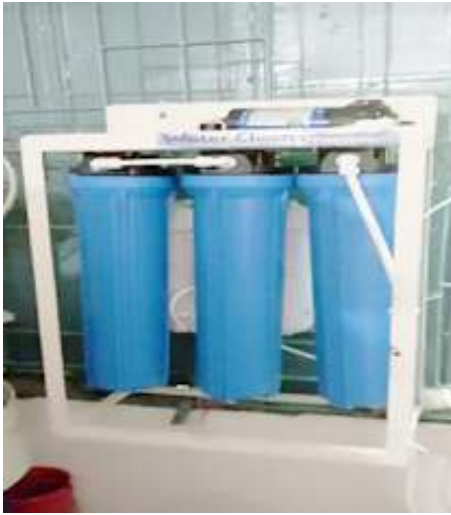
চিত্র: উচ্চমাত্রার লবণাক্ততার জন্য ছোটো আকারের রিভার্স অসমোসিস ইউনিট
