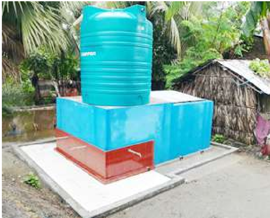
চিত্র: গ্রিড/সৌর শক্তি চালিত মাঝারি আকারের পন্ড স্যান্ড ফিল্টার
