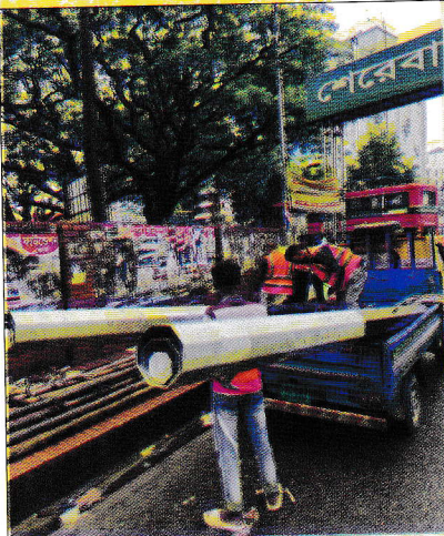
ঘূর্ণিঝড়ে ক্ষতিগ্রস্ত বিদ্যুৎ লাইন সংস্কার কার্যক্রম
