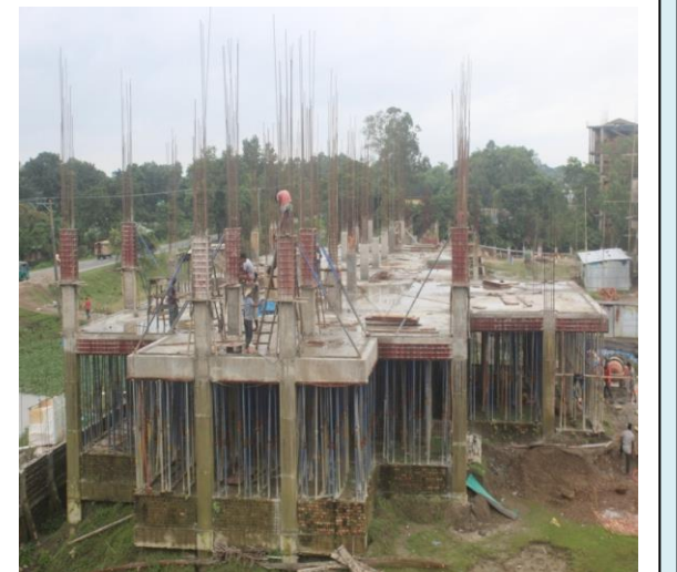
একাডেমিক ভবনের ২য় তলার কলাম কাস্টিং
