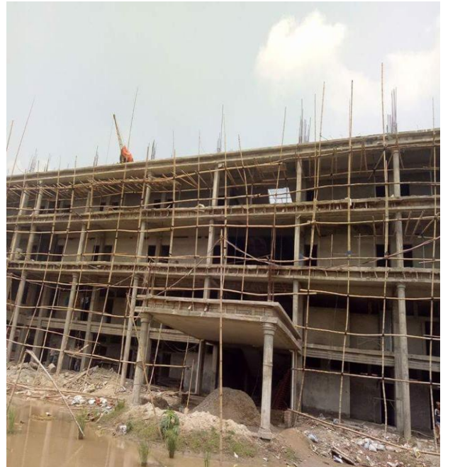
নির্মাণাধীন একাডেমিক ভবন
