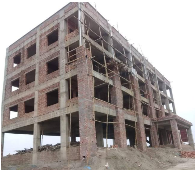
নির্মাণাধীন একাডেমিক ভবন
