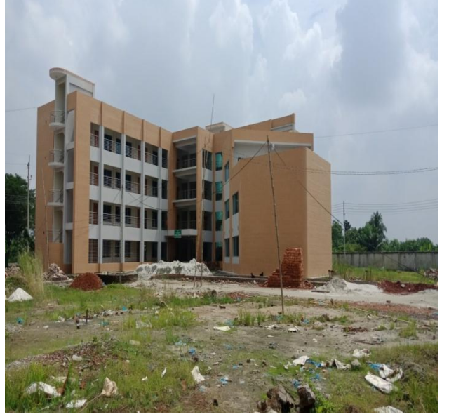
নির্মাণাধীন একাডেমিক ভবন, খুলনা
