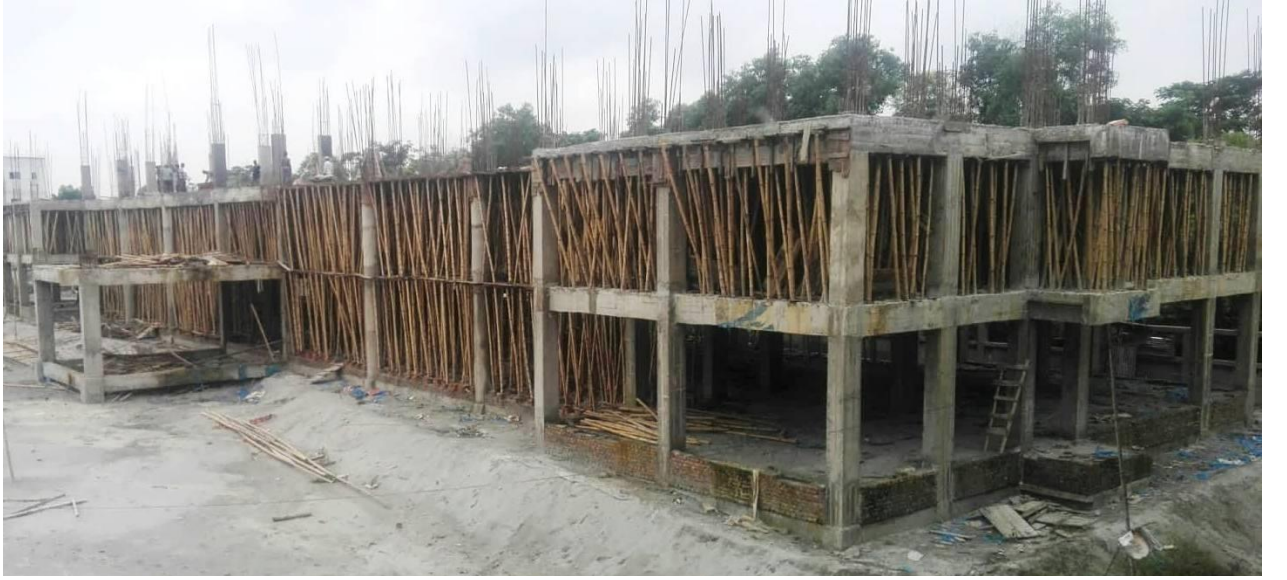
নির্মাণাধীন একাডেমিক ভবন
