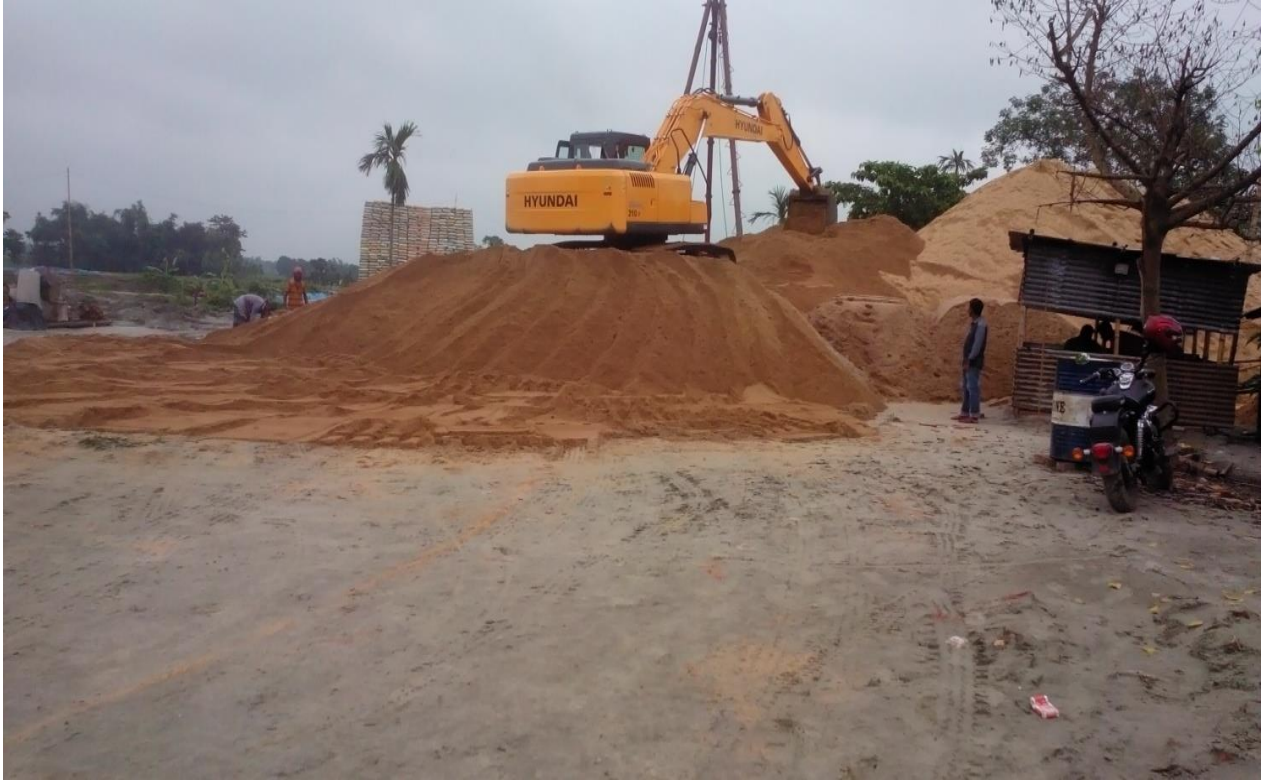
শেখ হাসিনা বিএসসি ইন টেক্সটাইল ইঞ্জিনিয়ারিং কলেজ, মেলান্দহ, জামালপুর স্থাপন প্রকল্পের পূর্ত নির্মাণ কাজের জন্য আনীত নির্মাণ সামগ্রী
