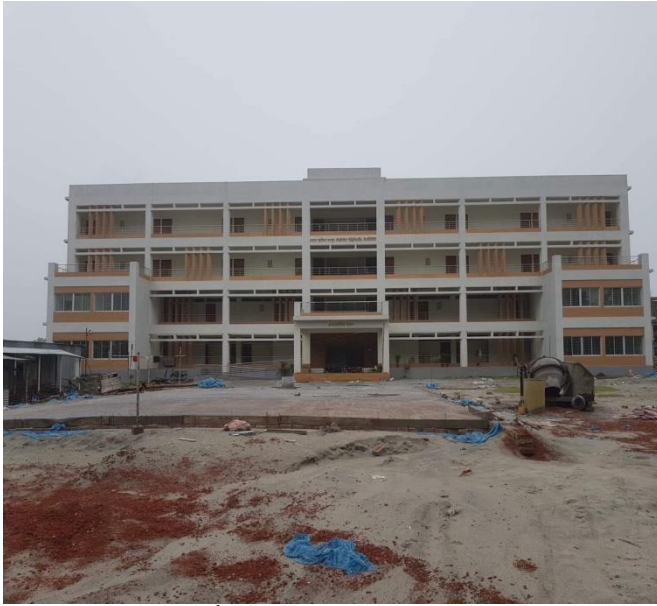
নির্মাণাধীন একাডেমিক ভবন
