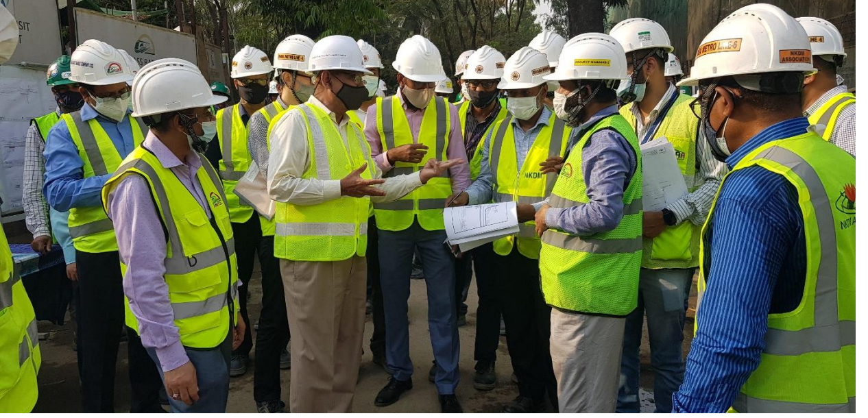
ব্যবস্থাপনা পরিচালক কর্তৃক ২৩ মার্চ ২০২২ তারিখ নির্মাণাধীন বিজয় সরণি মেট্রোরেল স্টেশনের নির্মাণ কাজ পরিদর্শন
