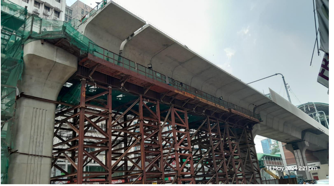
MRT Line-6 এর মতিঝিল থেকে কমলাপুর অভিমুখি ভায়াডাক্ট সেগমেন্ট উত্তোলন কাজের অগ্রগতি
