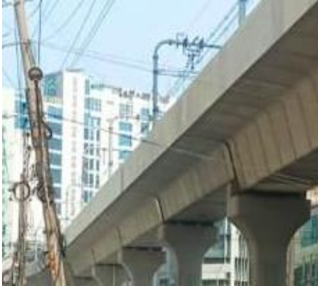
Metro Rail এর উচ্চ ক্ষমতা সম্পন্ন Catenary System এর উপর দিয়ে ডিস এবং ইন্টারনেট লাইনের ক্যাবল নেয়া হয়েছে
