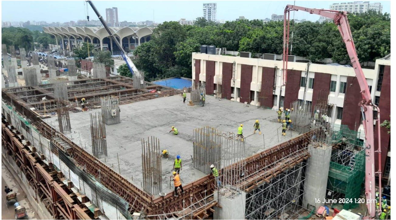
MRT Line-6 এর কমলাপুর টার্মিনাল মেট্রোরেল স্টেশনের Concourse Slab Casting চলমান
