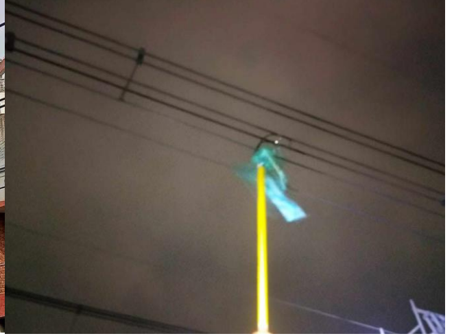
Metro Rail এর উচ্চ ক্ষমতা সম্পন্ন Overhead Catenary System এর উপর জড়িয়ে থাকা ফানুস অপসারণ করা হচ্ছে
