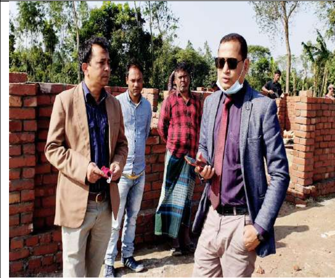
উপজেলা নির্বাহী অফিসার সদর, দিনাজপুর এডিপির কাজ পরিদর্শন করেন।
