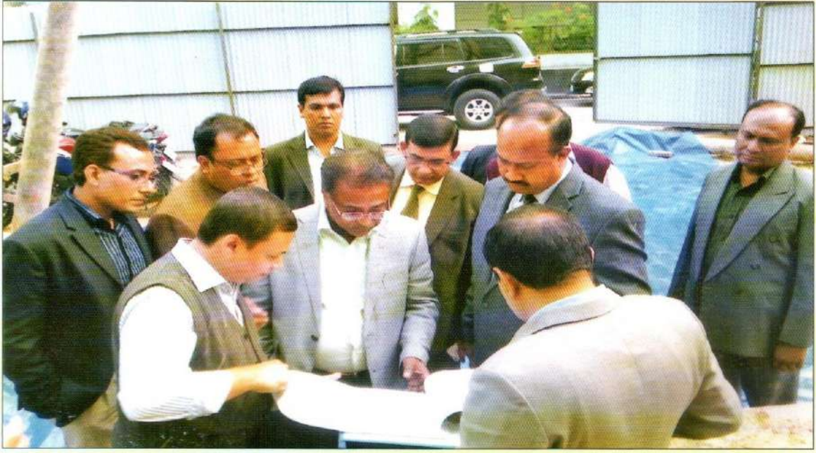
“শ্রম ভবন নির্মাণ” প্রকল্পের কাজ পরিদর্শন করছেন মাননীয় প্রতিমন্ত্রী জনাব মোঃ মুজিবুল হক, এম.পি, শ্রম কর্মসংস্থান মন্ত্রণালয়।
