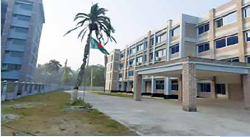
নবনির্মিত ঝালকাঠি নার্সিং কলেজ
