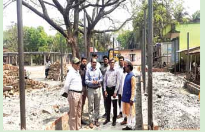
যশোর কৃষকের বাজার নির্মাণের কাজ পরিদর্শন করছেন কৃষি মন্ত্রণালয়ের উপসচিব জনাব কাজী আব্দুর রায়হান
