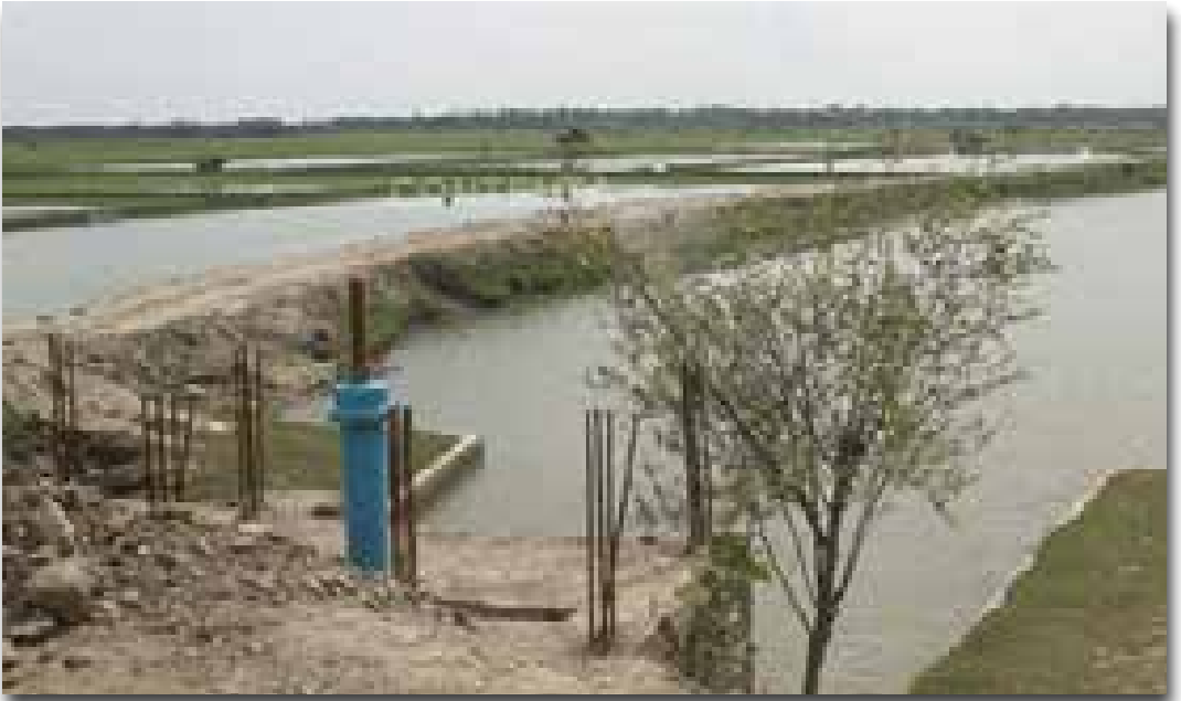
চিত্র : কার্যকর পানি ব্যবস্থাপনা অবকাঠামো নির্মাণের ফলে জলাবদ্ধতা নিরসন
