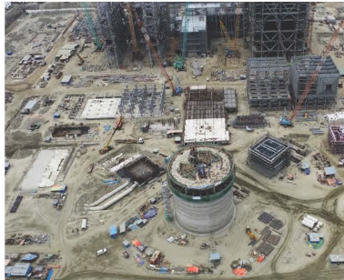
বিদ্যুৎ কেন্দ্রের ২৭৫ মিটার উচ্চ চিমনি নির্মাণ কার্যক্রম
