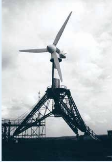
শিম্ব-পাটনাম উইন্ড টারবাইন বিশ্বের প্রথম মেগাওয়াট-সাইজ উইন্ড টারবাইন। ১৯৮১ সালে প্রথম উইন্ড মেশিন হিসেবে যুক্তরাষ্ট্রের ভার্মন্ট অঙ্গরাজ্যের ক্যাসলটন শহরে অবস্থিত বৈদ্যুতিক গ্রিডে অন্টারনোটিং কারেন্ট (এসি) সরবরাহ করে শিম্ব-পাটনাম উইন্ড টারবাইন
