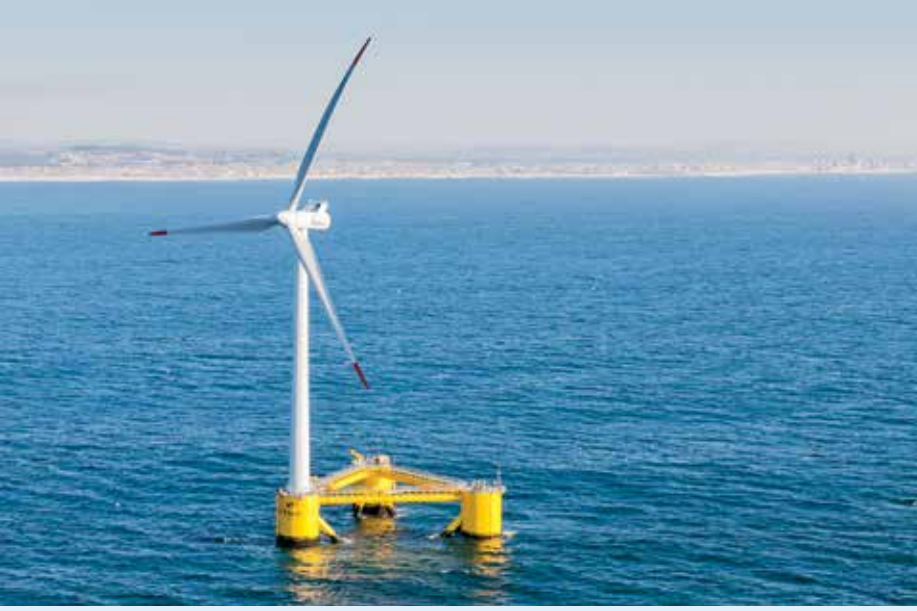
ফ্লোটিং উইন্ড টারবাইন গভীর সাগরে উত্তাল বেগে বয়ে চলা বাতাসের গতি ও প্রবাহের সাথে পাল্লা দিয়ে দুলতে থাকে। বাতাসের সঙ্গে সামঞ্জস্য বজায় রাখায় এই টারবাইনগুলো বায়ুশক্তির সর্বোচ্চ ব্যবহার নিশ্চিত করে
