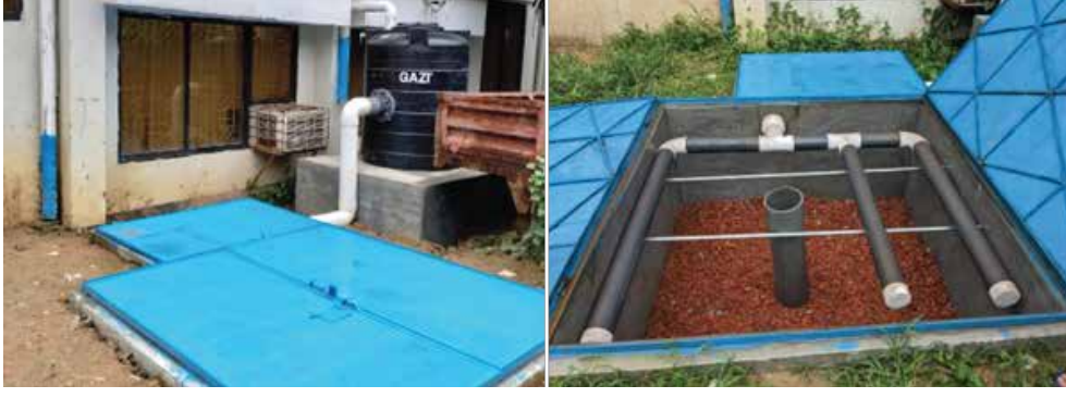
ছবি ২: ভূ-গর্ভস্থ পানির সংকটাপন্ন এলাকায় তথা ঢাকা মহনগরীতে ভূ-গর্ভস্থ একুইফারে পানির মজুদ (Reserve) বাড়াতে বৃষ্টির পানি দ্বারা নিয়ন্ত্রিত পুনর্ভরনের (Managed Aquifer Recharge) জন্য পরীক্ষামূলকভাবে স্থাপিত 'রিচার্জ ওয়েল'।
