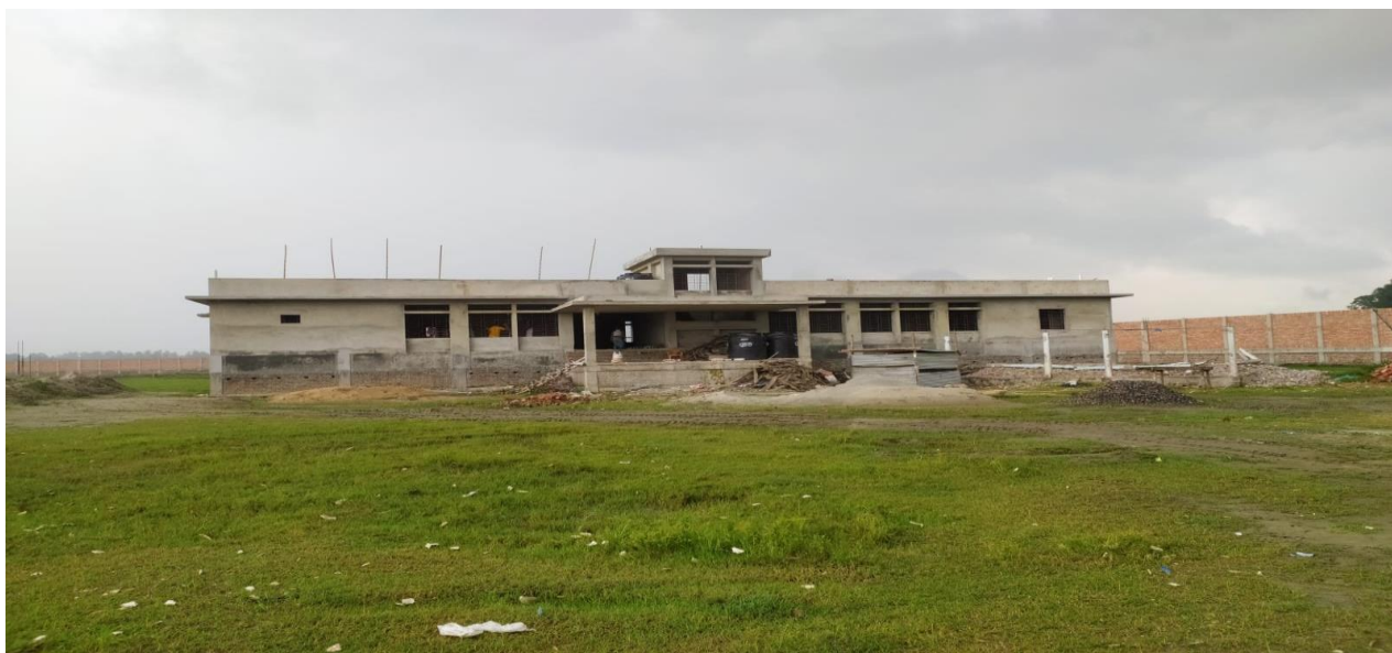
চিত্র ২৬ : ধানুয়া-কামালপুর স্থলবন্দরের নির্মাণাধীন প্রশাসনিক ভবন বাল্লা স্থলবন্দরে চলমান উন্নয়ন কার্যক্রমের খন্ড চিত্রঃ
