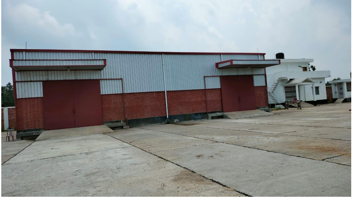
চিত্র ১৯: গোবড়াকুড়া-কড়ইতলী স্থলবন্দরের নবনির্মিত শেড
