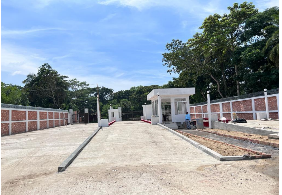
চিত্র ২৪: বিলোনিয়া স্থলবন্দরের চলমান উন্নয়ন কার্যক্রম
