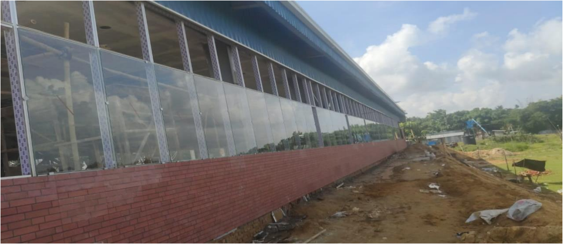
চিত্র ৩২: রামগড় স্থলবন্দরের উন্নয়ন কার্যক্রম
