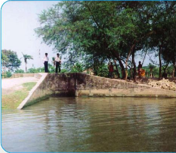
চিত্র: স্লুইস গেটের মাধ্যমে নদী হতে কম লবণাক্ত পানি অভ্যন্তরীণ খালে সংরক্ষণ
