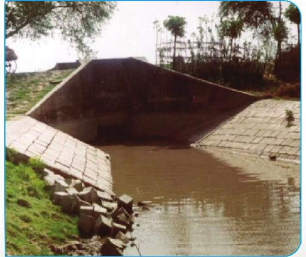
চিত্র: স্লুইস গেটের মাধ্যমে নদী হতে কম লবণাক্ত পানি অভ্যন্তরীণ খালে সংরক্ষণ
