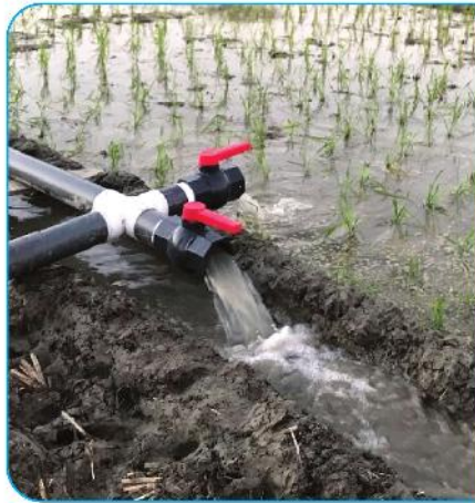
চিত্র: একটি শ্যালোটাইউবওয়েল ভিত্তিক ভূ-পৃষ্ঠস্থ পিভিসি পাইপ সেচ বিতরণ ব্যবস্থা
