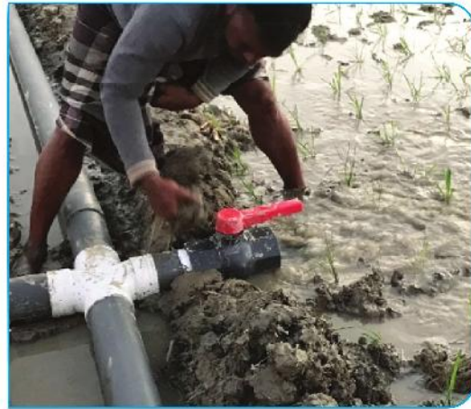
চিত্র: একটি শ্যালোটাইউবওয়েল ভিত্তিক ভূ-পৃষ্ঠস্থ পিভিসি পাইপ সেচ বিতরণ ব্যবস্থা
