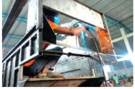
চিত্র ২৪ থ্রেসিং সেকশনের ফ্রেম তৈরি হচ্ছে
