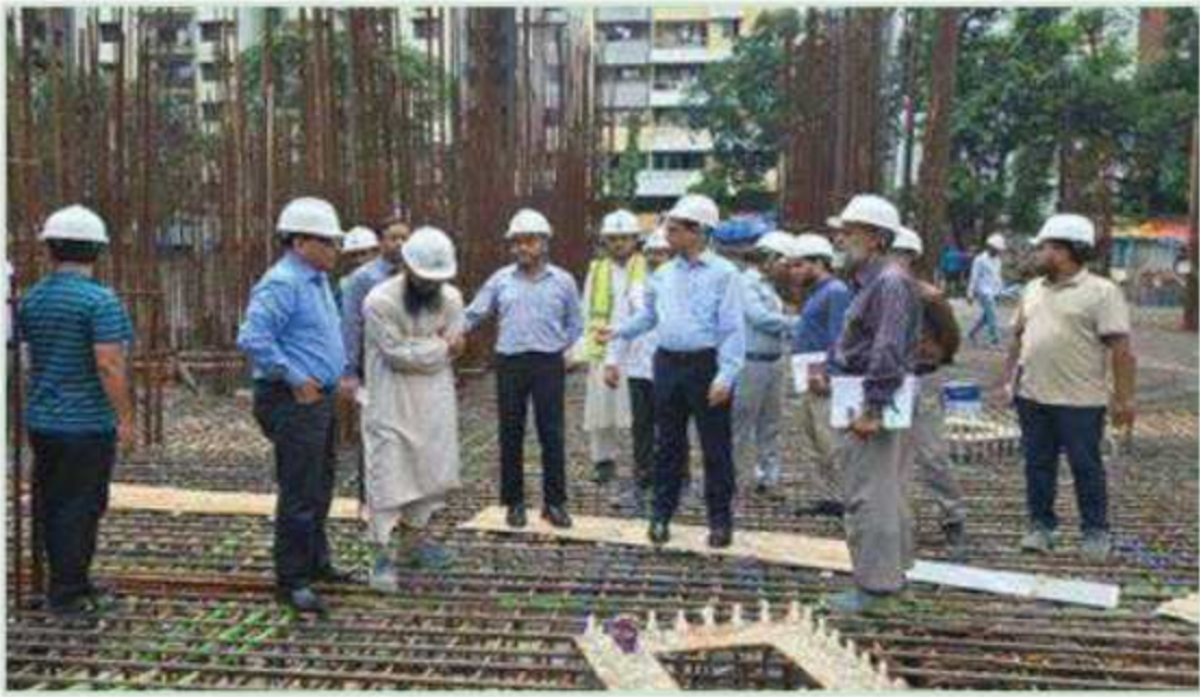
চেয়ারম্যান, বিপিসি কর্তৃক ঢাকায় পদ্মা অয়েল কোম্পানীর ভবনের নির্মাণ কার্যক্রম পরিদর্শনের খণ্ডচিত্র
