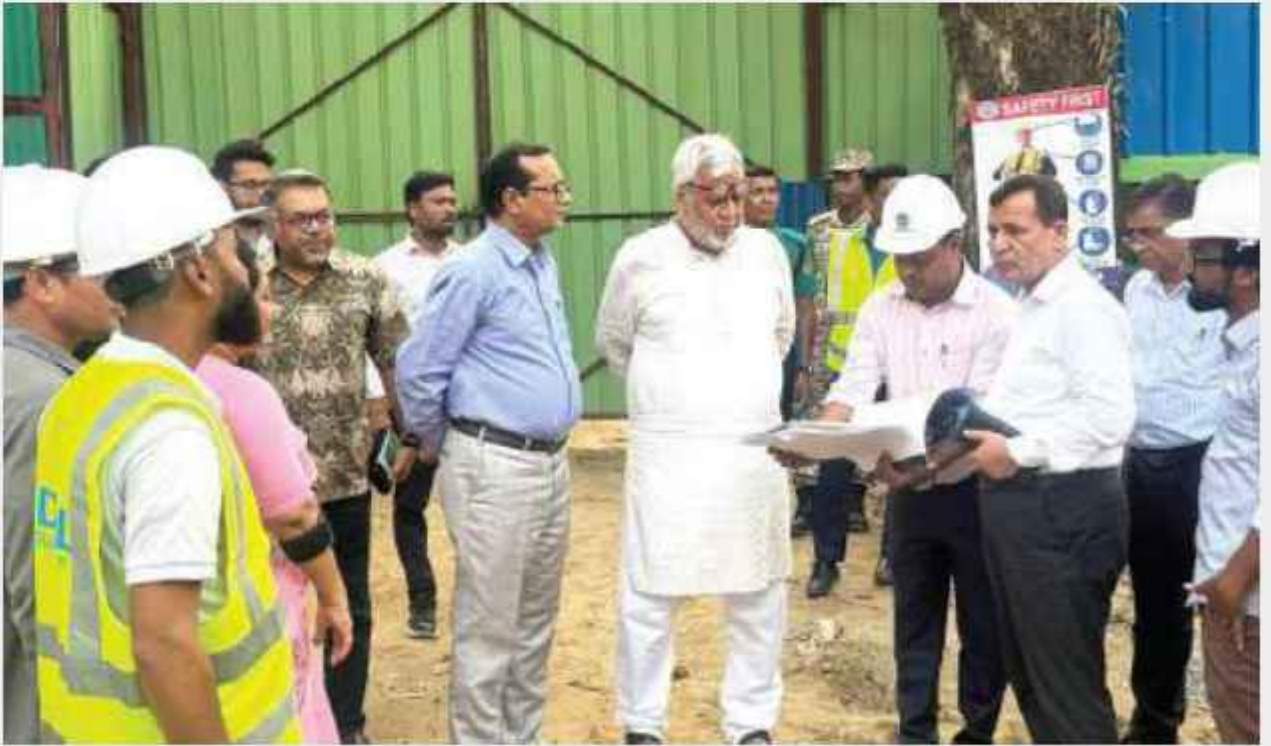
বিপিসি'র নির্মাণাধীন অফিস ভবনের নির্মাণকাজ পরিদর্শনে মাননীয় উপদেষ্টা, বিদ্যুৎ, জ্বালানি ও খনিজ সম্পদ মন্ত্রণালয়
