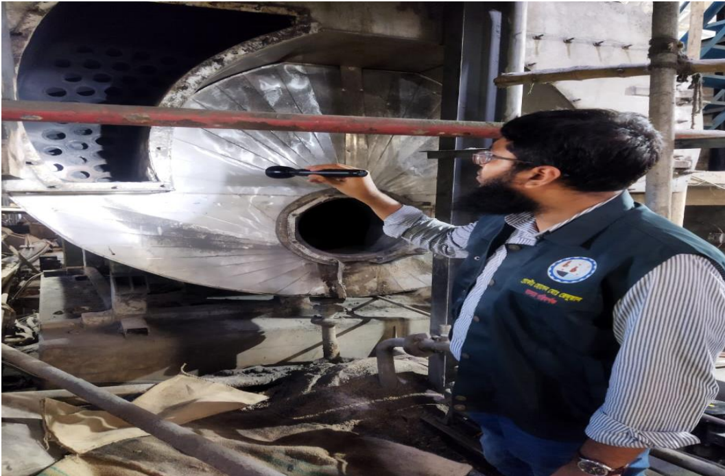
ময়মনসিংহ কার্যালয়ের অধীন বয়লার পরিদর্শন
