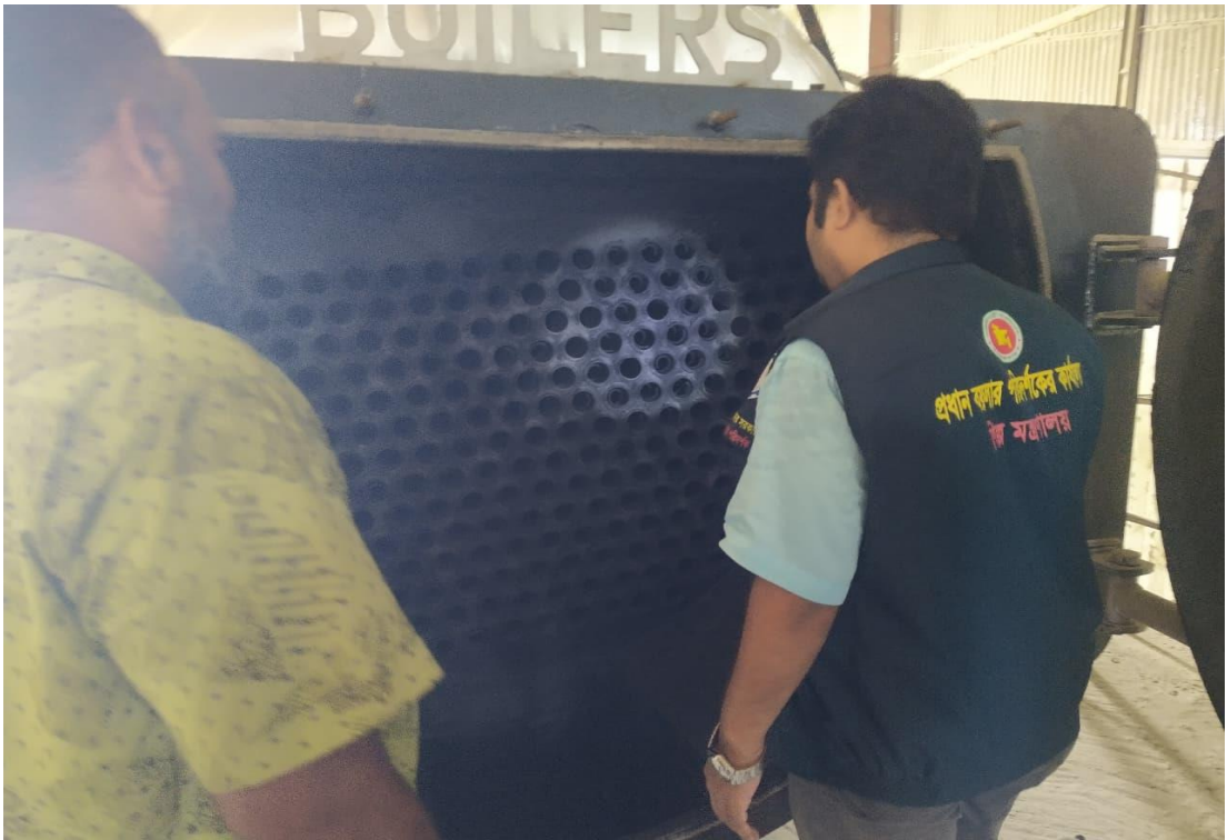
ময়মনসিংহ কার্যালয়ের অধীন বয়লার পরিদর্শন
