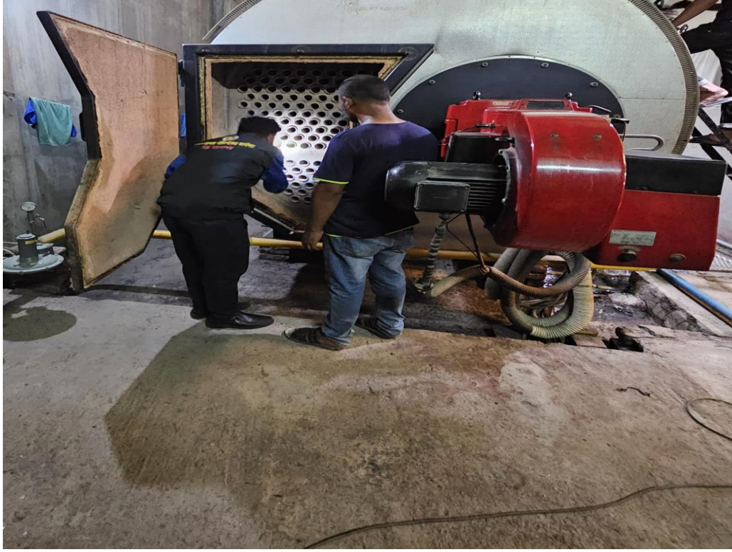
গাজীপুর কার্যালয়ের অধীন বয়লার পরিদর্শন
