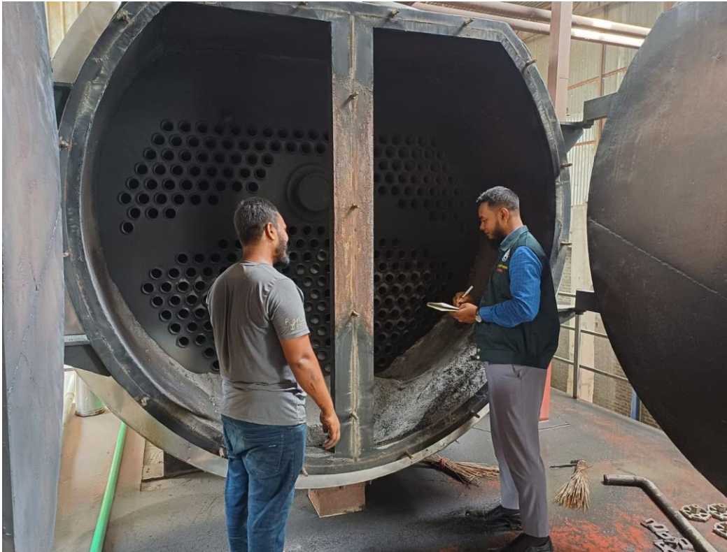
রাজশাহী কার্যালয়ের অধীন বয়লার পরিদর্শন
