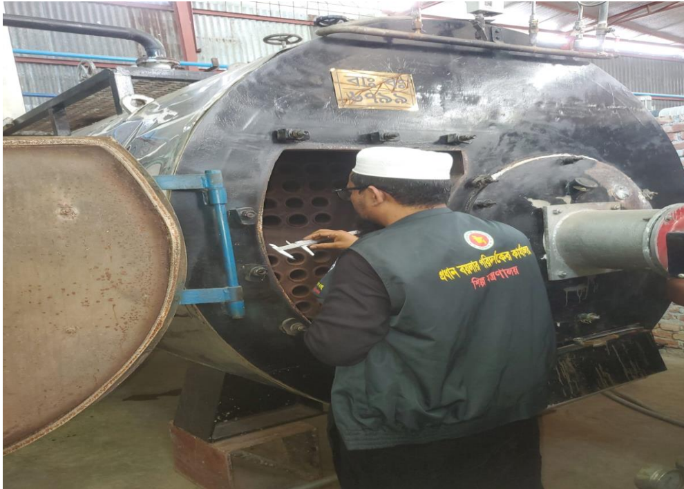
সিলেট কার্যালয়ের অধীন বয়লার পরিদর্শন
