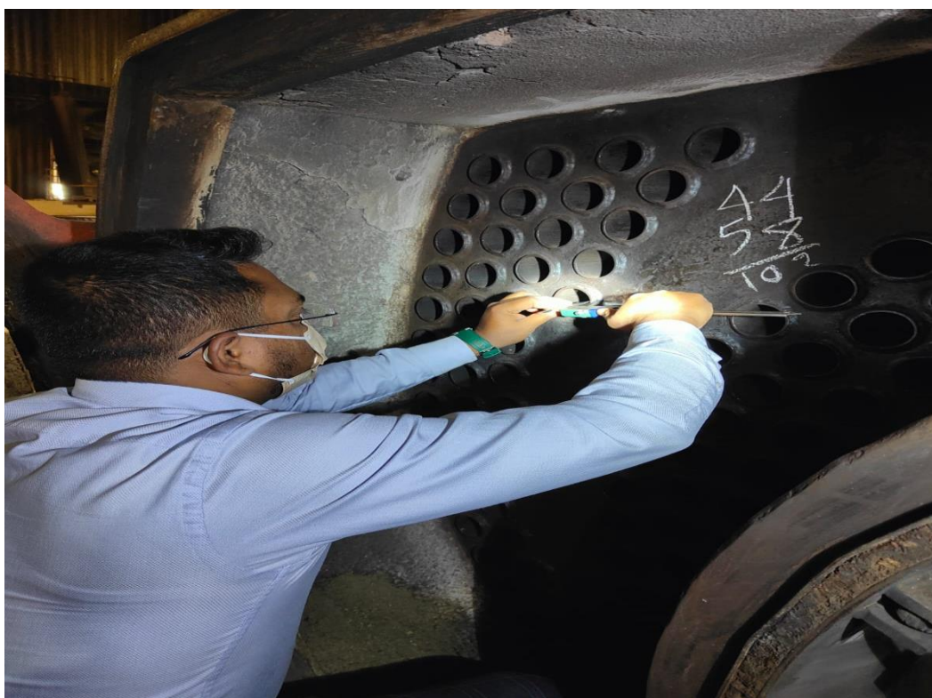
রংপুর কার্যালয়ের অধীন বয়লার পরিদর্শন
