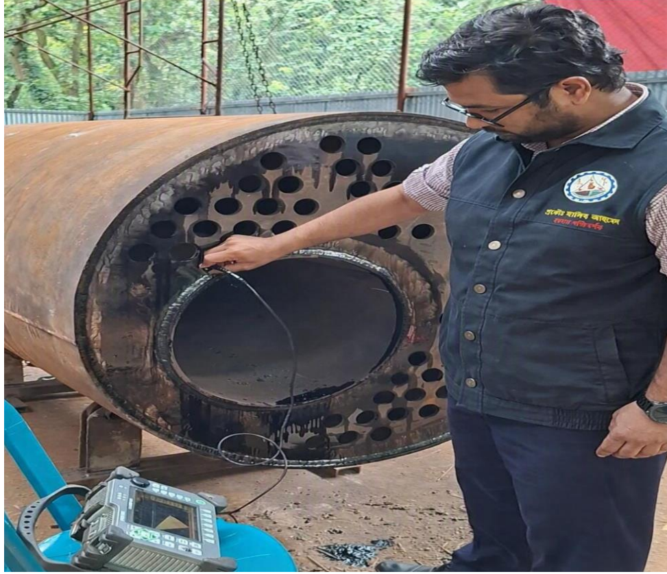
বয়লার নির্মাণকালীন পরিদর্শন
