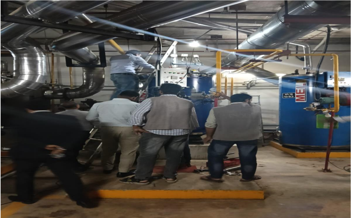
চট্টগ্রাম কার্যালয়ের অধীন বয়লার পরিদর্শন
