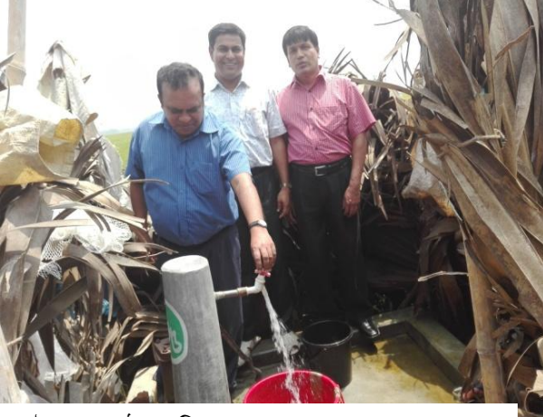
ভৌত অবকাঠামো বিভাগের যুগ্ম-প্রধান মহোদয়ের প্রকল্প পরিদর্শন
