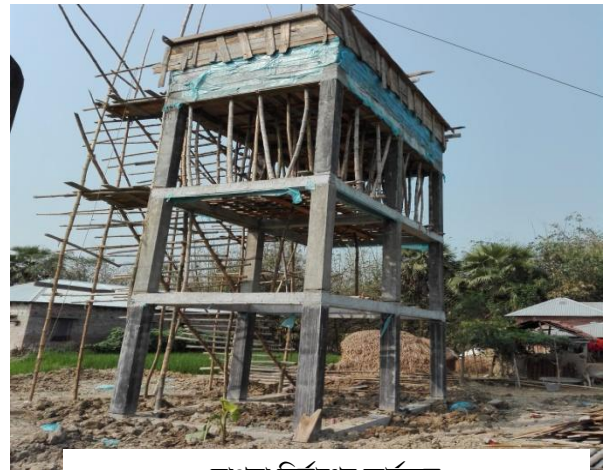
স্থাপনা নির্মাণের কার্যক্রম
