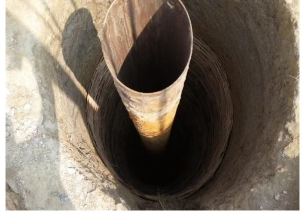
চিত্রঃ একেজো গভীর নলকূপের মালামাল উত্তোলন প্রক্রিয়া
