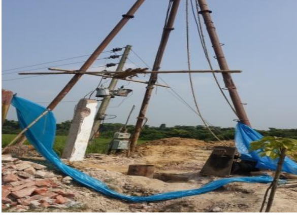
চিত্রঃ একেজো গভীর নলকূপের মালামাল উত্তোলন প্রক্রিয়া
