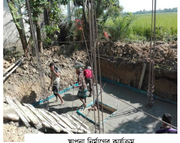
স্থাপনা নির্মাণের কার্যক্রম
