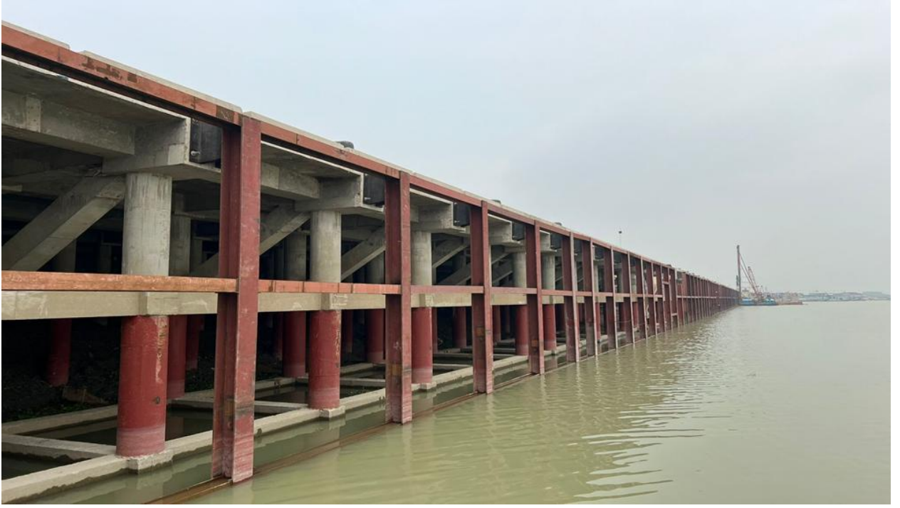
নগরবাড়ী প্রকল্পের আওতায় নদী বন্দর এলাকার নির্মিত আরসিসি জেটির চিত্রঃ
