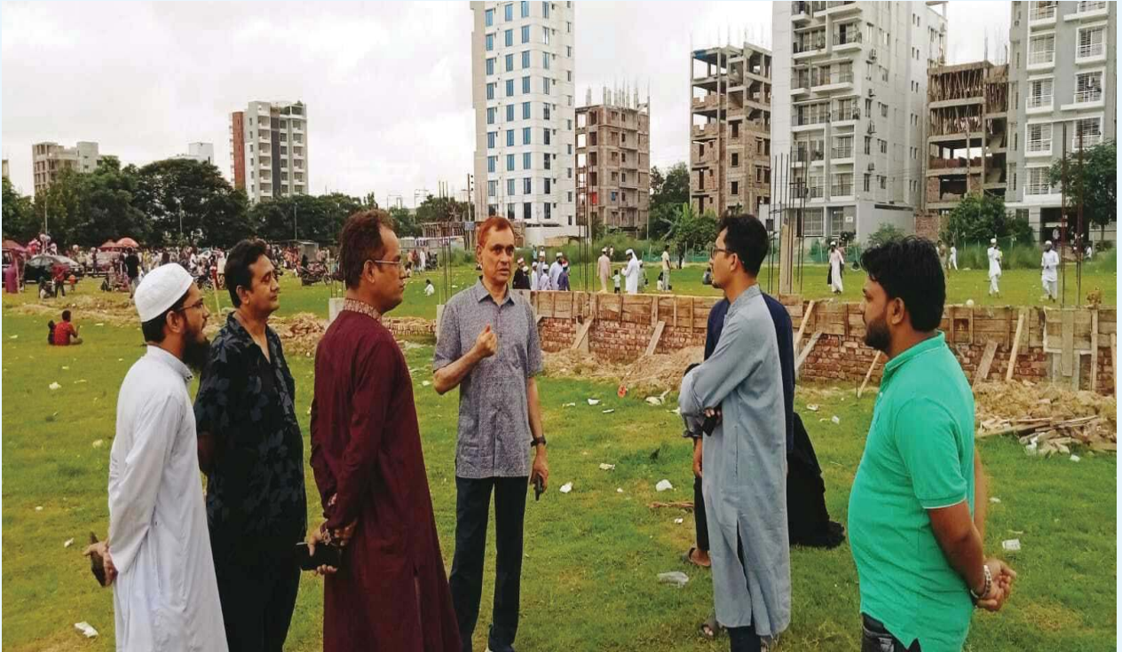
মহাপরিচালক বিয়াম কর্তৃক সীমানা প্রাচীর নির্মাণ কার্যক্রম পরিদর্শন।
