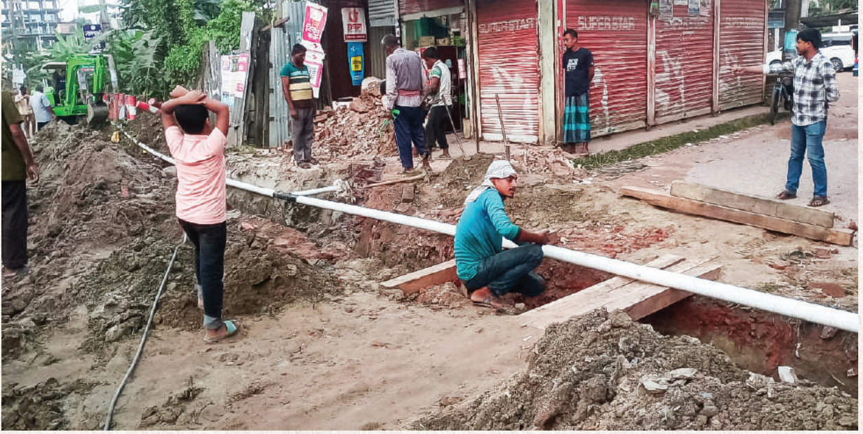
■ সড়ক ও জনপথ বিভাগ, লক্ষ্মীপুরের অর্থায়নে লক্ষ্মীপুর শহর সংযোগ সড়ক ও লক্ষ্মীপুর - চর আলেকজান্ডার সড়কে নির্মাণাধীন ৩ ইঞ্চি ব্যাস ৪ বার চাপবিশিষ্ট পাইপলাইন নির্মাণ কাজ
