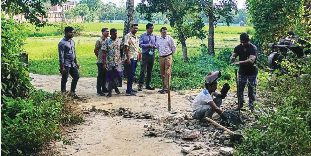
। ব্যবস্থাপনা পরিচালক কর্তৃক নানকরা, চৌদ্দগ্রাম, কুমিল্লায় অবৈধ গ্যাস সংযোগ বিচ্ছিন্নকরণ কার্যক্রম তদারকি
