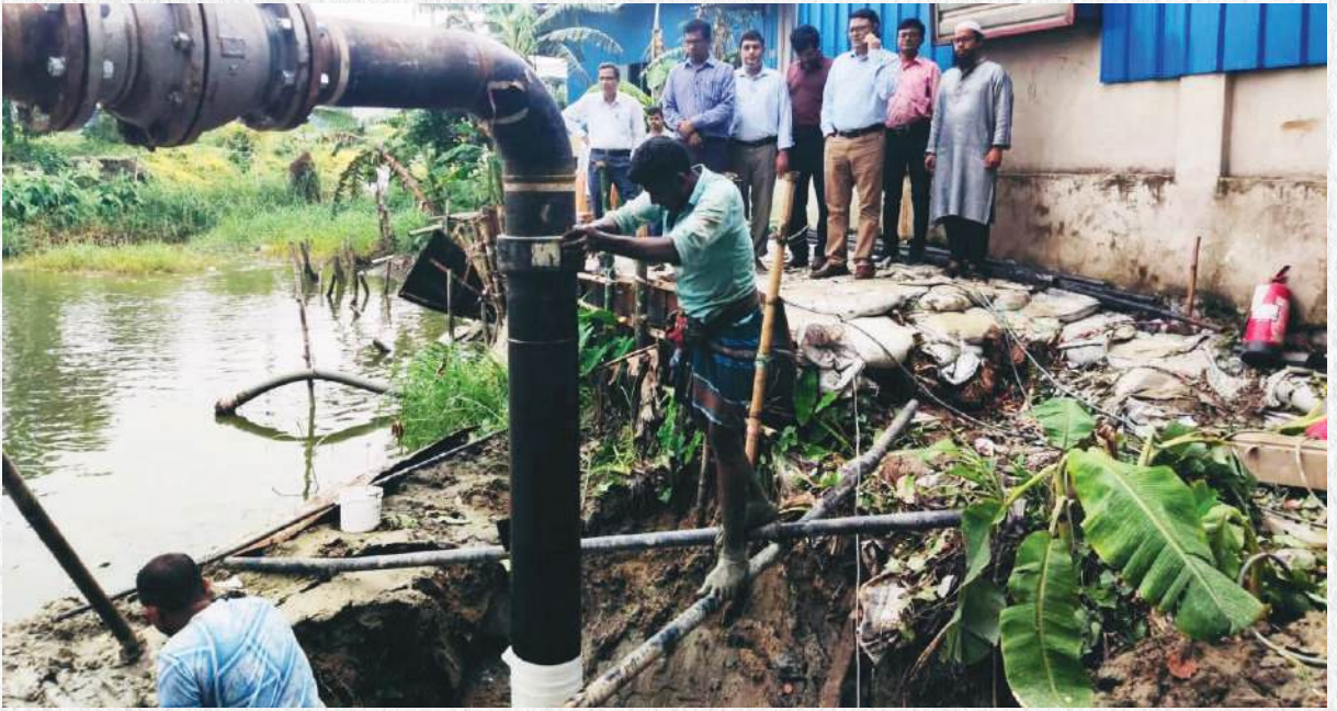
। ব্যবস্থাপনা পরিচালক কর্তৃক ফেনী-চৌদ্দগ্রাম ৮” ব্যাসের ৪ বার বিতরণ লাইনে মিটারিং স্টেশন স্থাপন কার্যক্রম পরিদর্শন
