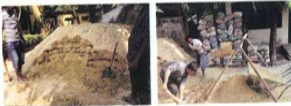
চিত্র ১০: তার জালির চালুনির সাহায্যে ঢেলে আবর্জনা, গাছের শিকড় ও কংকর পরিষ্কারকরণ
