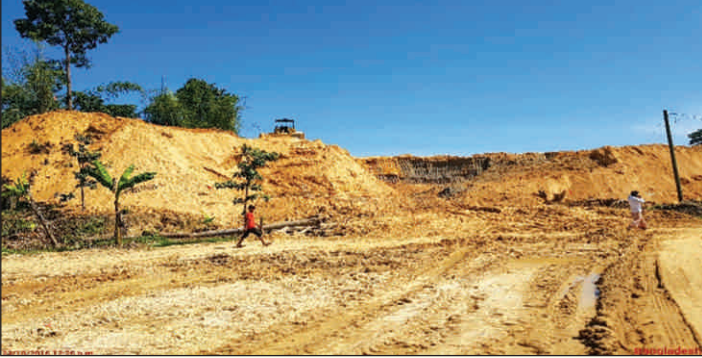
চিত্রঃ পাহাড় কেটে রাস্তা তৈরী
